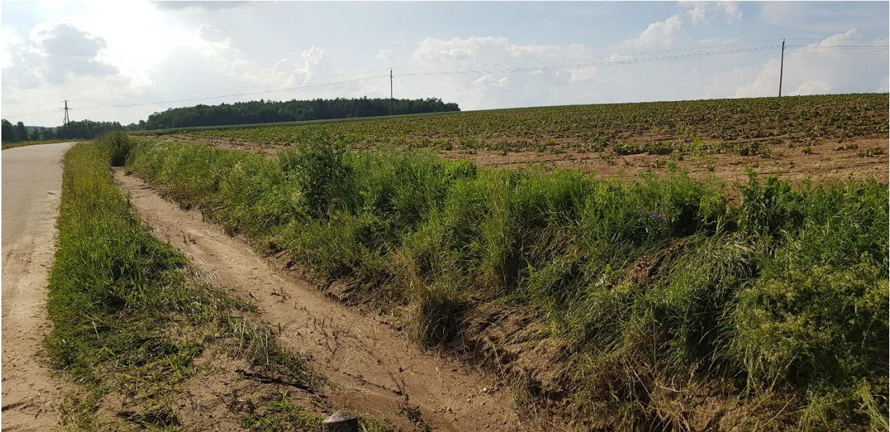
Abb. 69 Ein mit Sediment aufgefüllter Entwässerungsgraben zwischen Oberhöflein und Fronsburg. Foto: G. Lützenburg, 2018.
