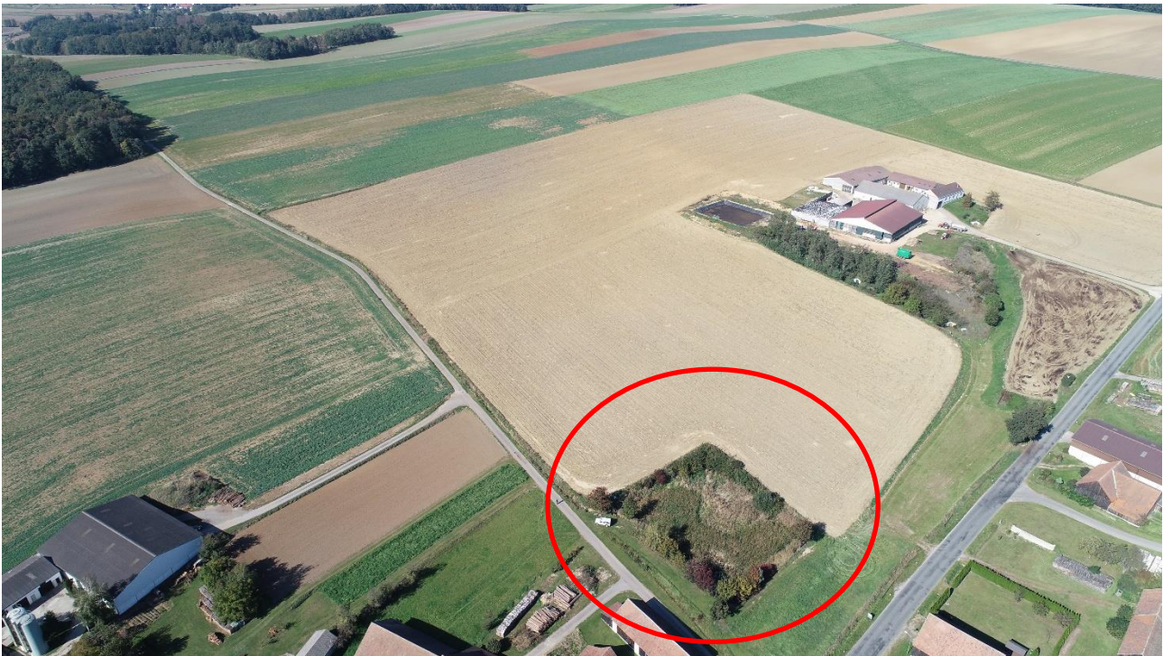
Abb. 71 Wasser- und Sedimentretentionsbecken unterhalb des Filterdamms in Waschbach. Foto (mit Drohne): G. Lützenburg, 2018
