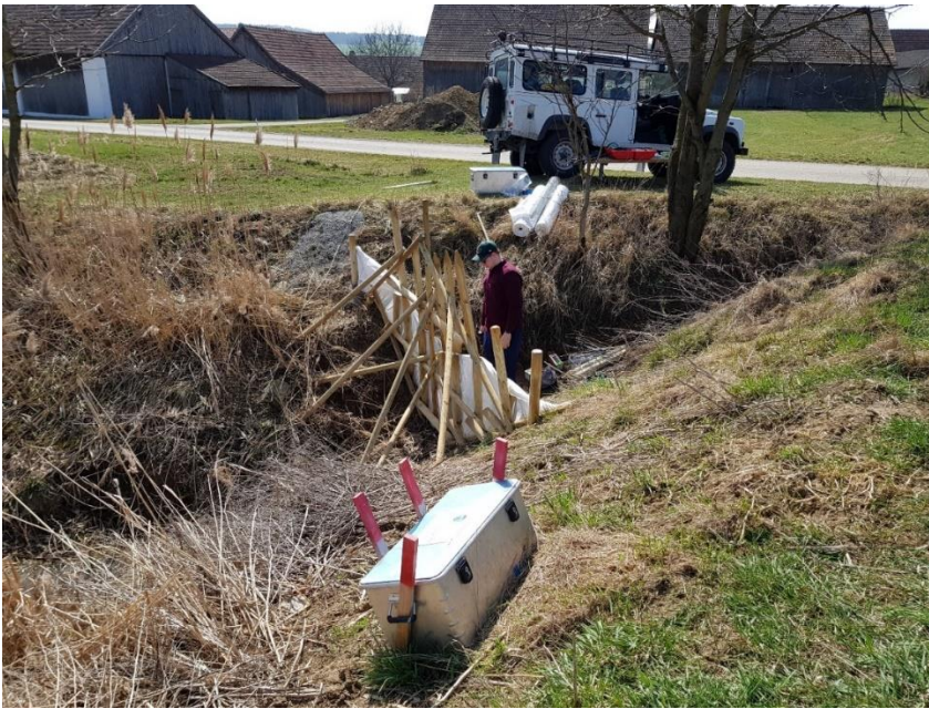
Abb. 29 In einem Entwässerungsgraben in Waschbach installierter Filterdamm. Foto: G. Lützenburg, 2018.
