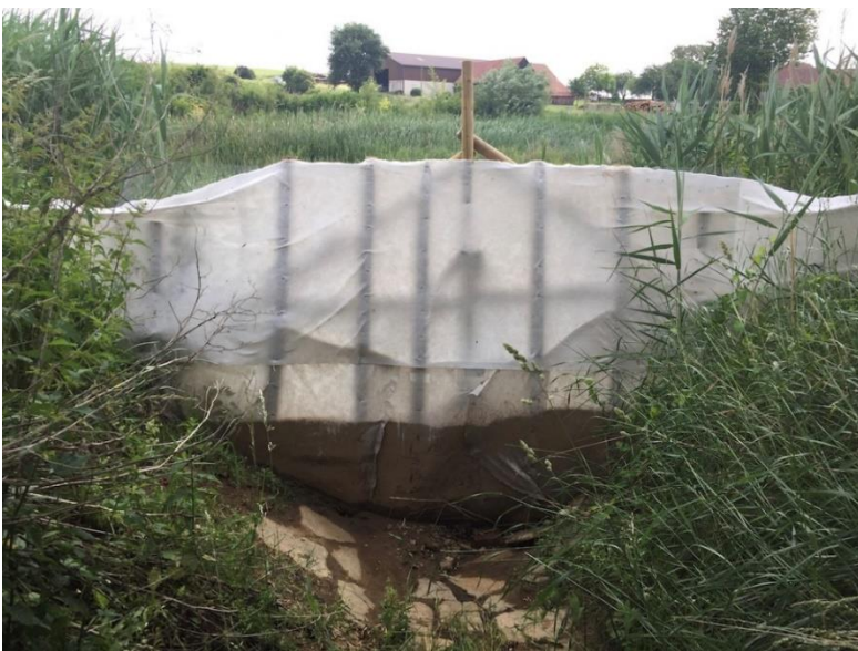
Abb. 68 Geringfügige Sedimentablagerung hinter einem Filterdamm nahe Waschbach. Der Filter ist nach einem Starkregenereignis im Frühjahr 2018 an der Basis gerissen. Foto: G. Lützenburg, 2018.
