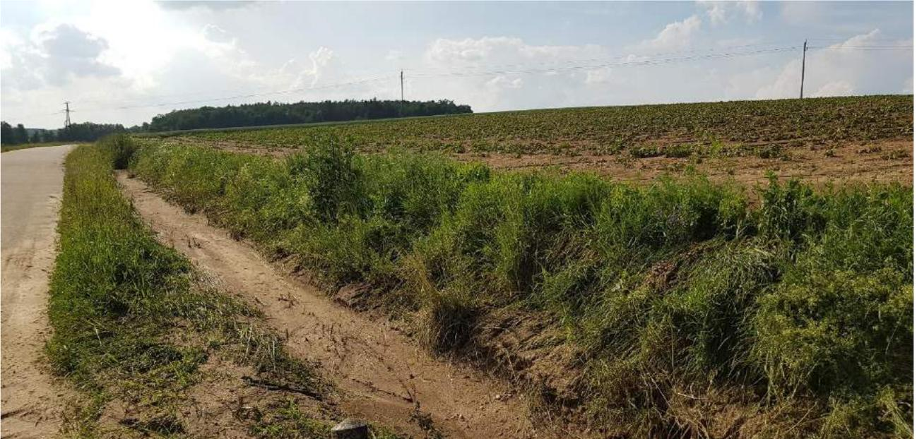
Abb. 69 Ein mit Sediment aufgefüllter Entwässerungsgraben zwischen Oberhöflein und Fronsburg. Foto: G. Lützenburg, 2018.
