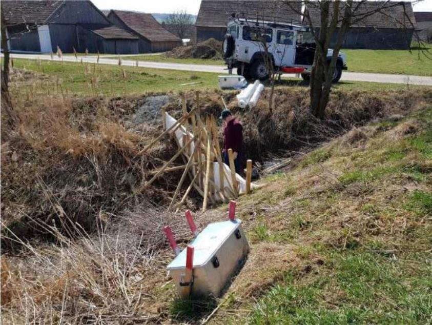
Abb. 29 In einem Entwässerungsgraben in Waschbach installierter Filterdamm. Foto: G. Lützenburg, 2018.
