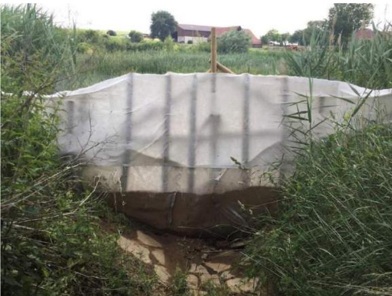
Abb. 68 Geringfügige Sedimentablagerung hinter einem Filterdamm nahe Waschbach. Der Filter ist nach einem Starkregenereignis im Frühjahr 2018 an der Basis gerissen. Foto: G. Lützenburg, 2018.
